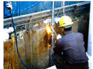
土木工事現場で活躍中
